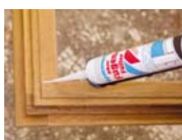
Wypełnianie fug dla ochrony przed wilgocią
