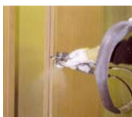
Naniesienie metodą natryskową warstwy końcowej
